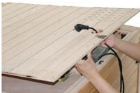
Obr.-22 Veňte napájací kábel cez vonkajší horný panel
