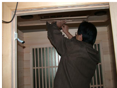
Obr.-13 Vedení kabelů ohřevačů na panelech prostřednictvím příslušného otvoru
