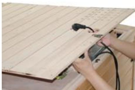
Obr.-22 Veďte napájecí kabel skrz vnější horní panel
