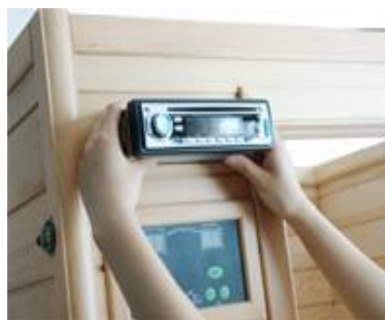
Obr.-16.1 Pripojenie prehrávača
