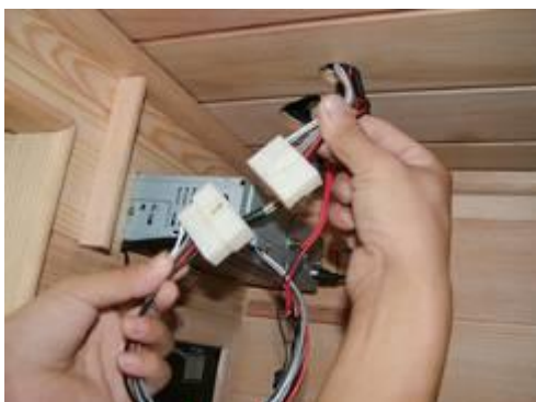
Obr.-17 Prepojenie konektorov prehrávača
