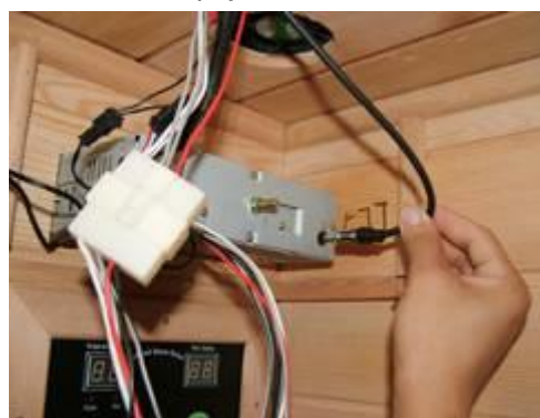
Obr.-18 Prepojenie konektorov snímača
