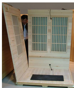
Obr.-5 Připojení levého panelu
